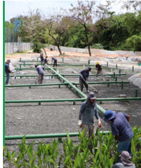
Obras do Jardim Filtrante.
