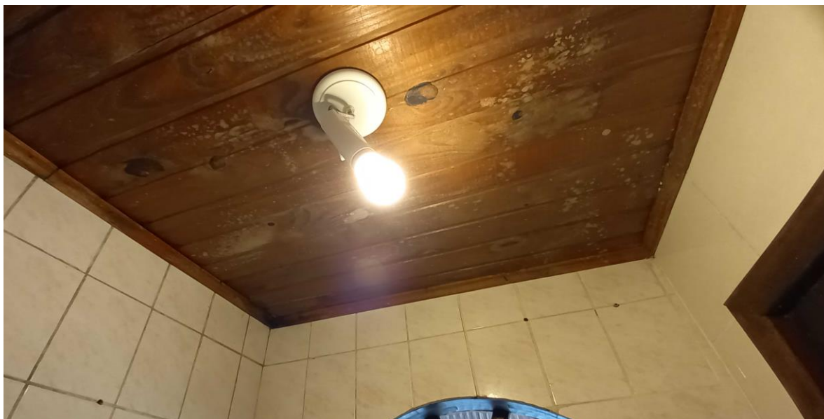
Figura 6: Detalhe de infiltração no forro da edificação.
